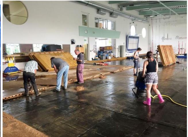
**Der nasse Fußboden wurde mit der Kettensäge herausgeschnitten.**
